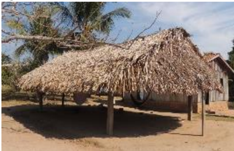
Figura 46 - Barraco ao lado da casa
